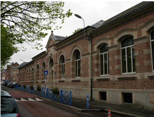
Cliché 33 (24 avril 2008) La façade sur rue et la contre-allée du boulevard
