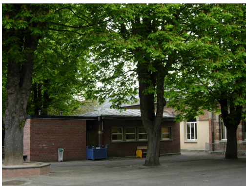
Cliché 41 (24 avril 2008) La cour principale coupée par le bâtiment des sanitaires
