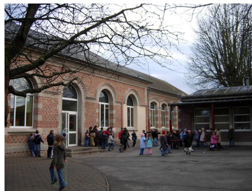
Cliché 14 (10 janvier 2008) Le contraste entre les fenêtres hautes du bâtiment initial (à gauche) et les fenêtres en bandeau des adjonctions (à droite)
