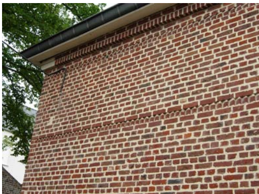
Cliché 157 (2 juillet 2008) Exemple de calepinage de la brique
